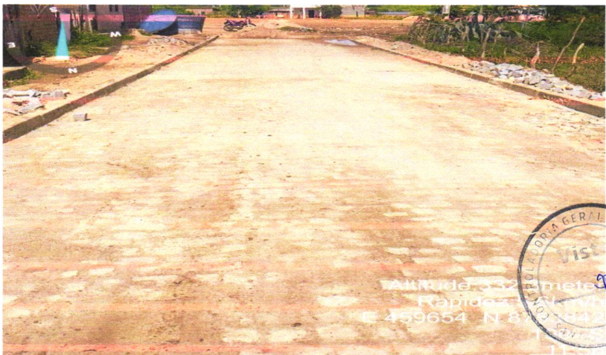
Execução de pavimentação Rua projetada 04
