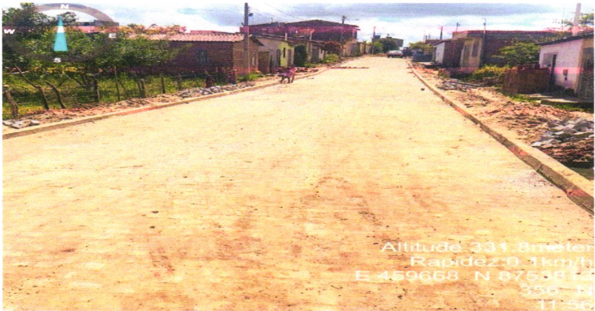
Execução de pavimentação Rua projetada 04
